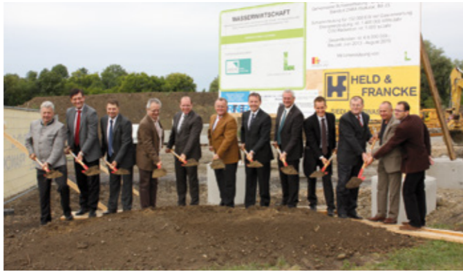
Spatenstich mit Landeshauptmann Hans Niessl, zahlreicher Bürgermeister und Vertreter der Mitgliedsgemeinden und der Landesregierung
